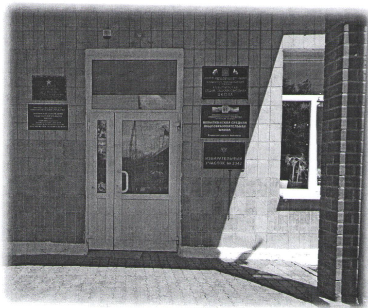
Фото 4 Входная площадка перед дверью.
